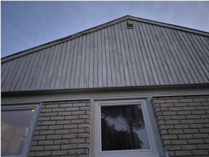
Rötskadad panel på gavelspets.
