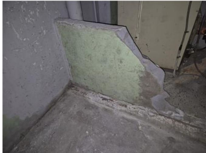
Innervägg i källare byggd med blåbetong.
